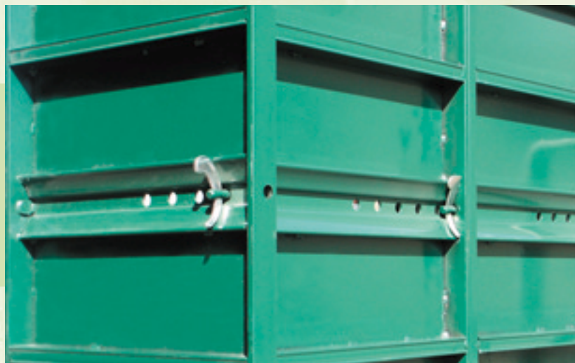
Pilar combinando paneles de 500 x 3000 y reforzados de 750 x 3000 mm.
