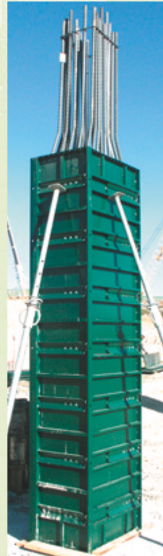
Pilar combinando paneles de 500 x 3000 y reforzados de 750 x 3000 mm.
